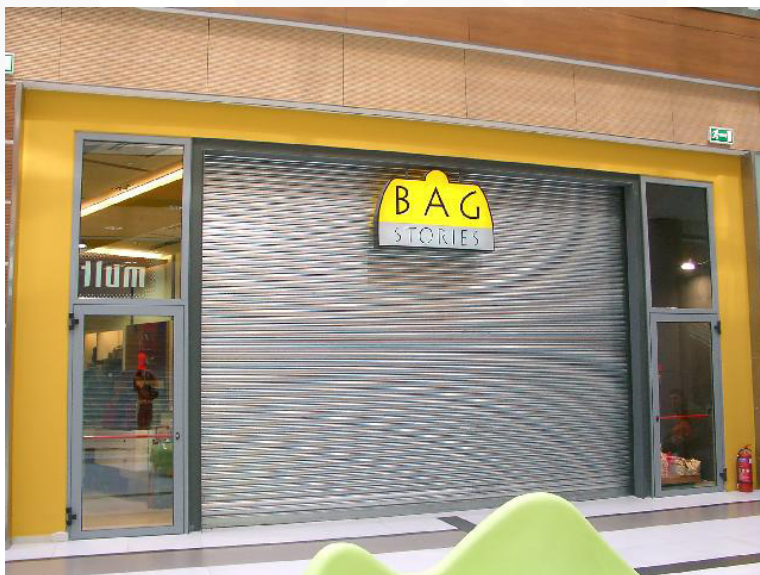
Πυράντοχο Ρολό με συνδυασμό εκατέρωθεν πυράντοχων υαλοστασίων
